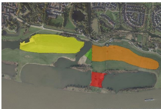
Luchtfoto huidige situatie
